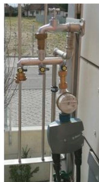
Figura 9: Control con válvulas solenoides en el interior (izquierda) y con unidad de control a batería (2 zonas) en el exterior (derecha)
