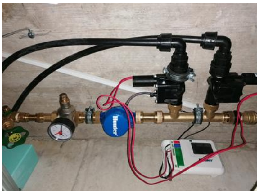
Figura 9: Control con válvulas solenoides en el interior (izquierda) y con unidad de control a batería (2 zonas) en el exterior (derecha)
