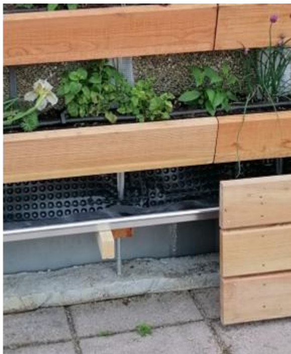
Figura 10: Canal de drenaje y paneles en la parte inferior
