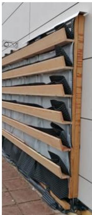
Figura 8: Bandejas de plantación con lámina y vellón
