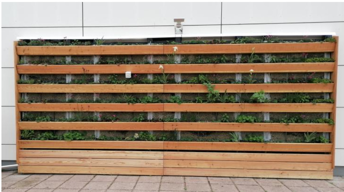
Figura 11: Muro verde EVAPO+ recién terminado y plantado en primavera
