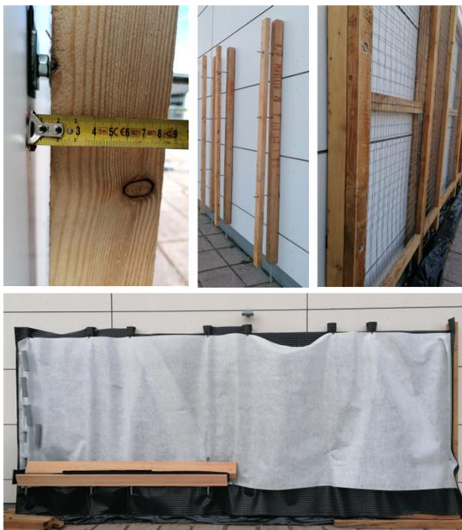
Figura 5: Montaje del montante con separador y pared trasera de malla, lámina con hoyuelos y vellón
