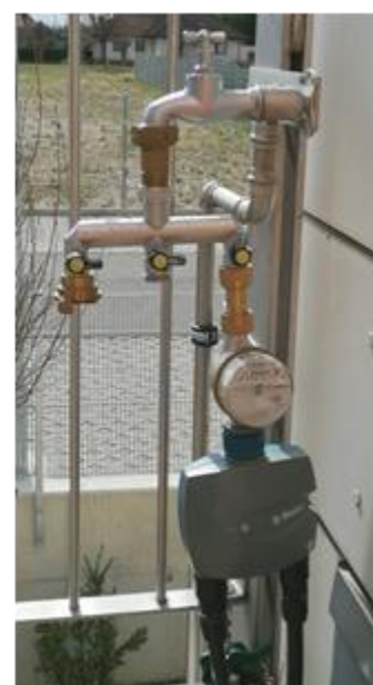
9. irudia: Kontrola solenoide-balbulen bidez barnealdean (ezkerrean) eta bateriaren kontrol-unitatearekin (2 zona) kanpoaldean (eskuinean)
