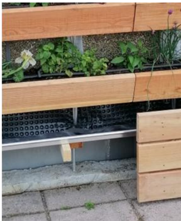
10. irudia: Drainatze-kanala eta beheko panelak
