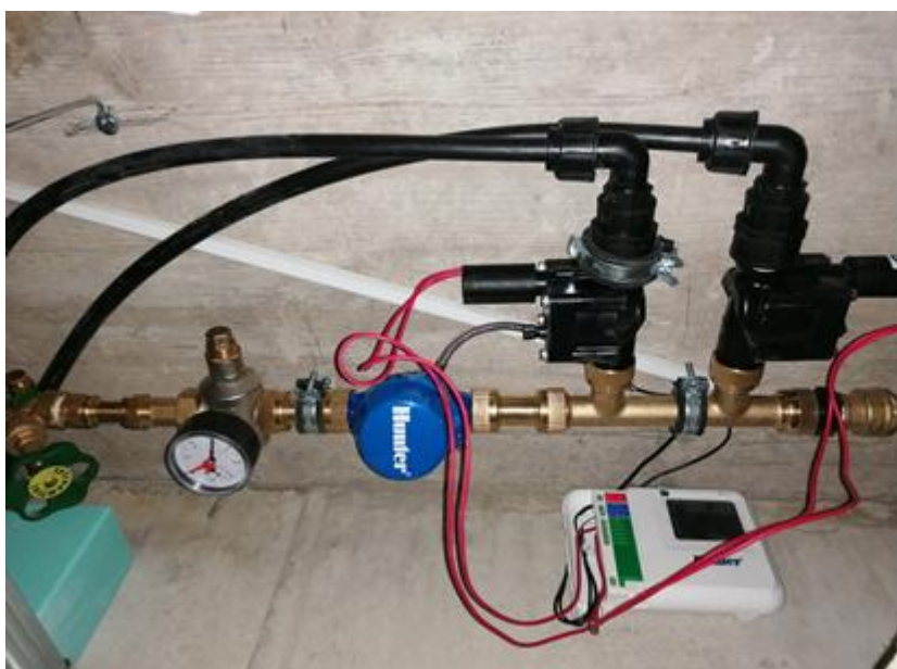
9. irudia: Kontrola solenoide-balbulen bidez barnealdean (ezkerrean) eta bateriaren kontrol-unitatearekin (2 zona) kanpoaldean (eskuinean)
