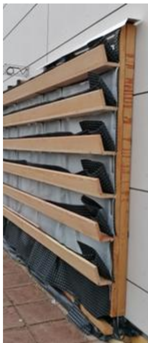
8. irudia: Landatzeko erretiluak paper aluminiozko eta artilezko estalkiarekin
