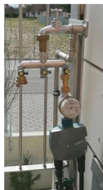
Fíor 9: Rialú le comhlaí solenoid laistigh (ar chlé) agus le haonad rialaithe ceallraí (2 chríos) lasmuigh (ar dheis)
