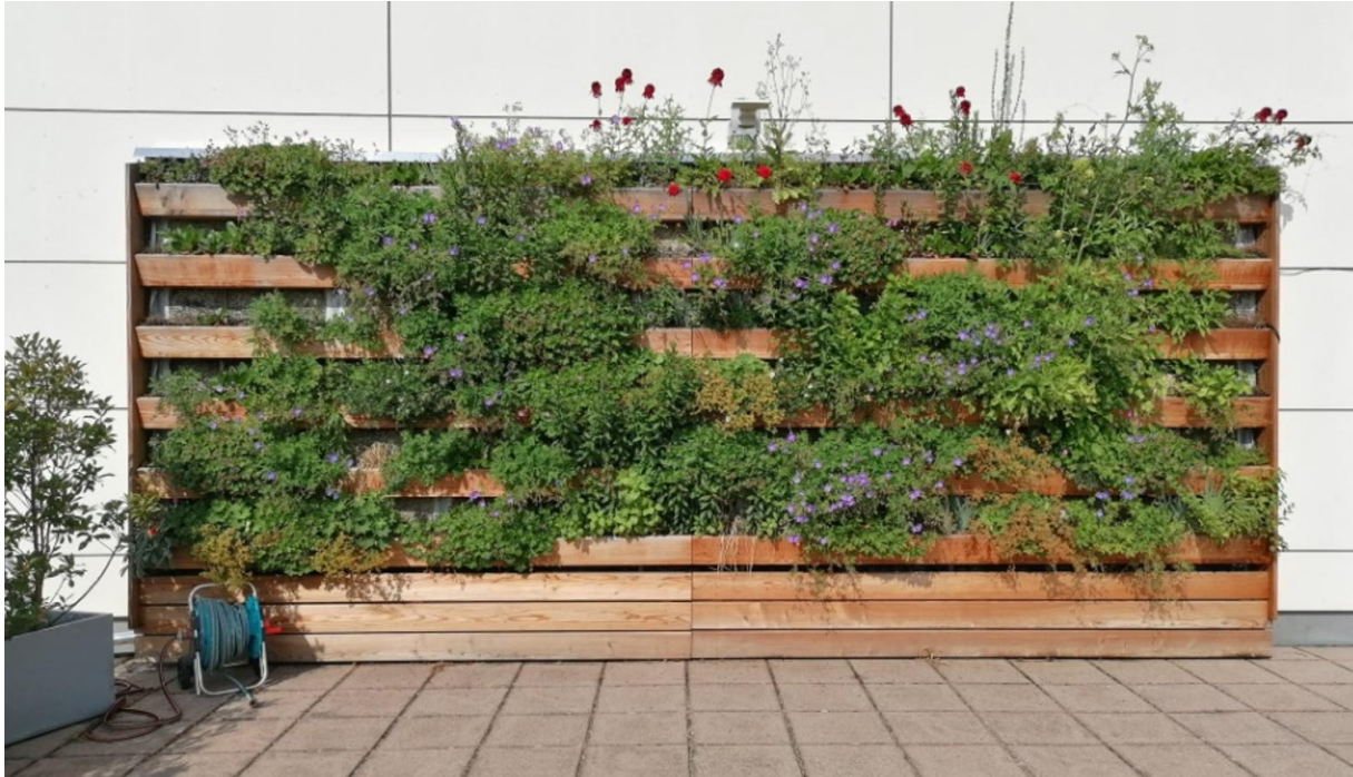
Fíor 1: Balla glas EVAP0+ suite ar bhalla an fhoirgnimh
