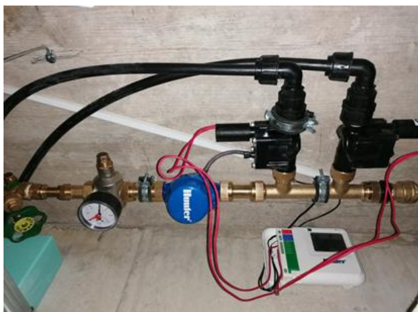
Fíor 9: Rialú le comhlaí solenoid laistigh (ar chlé) agus le haonad rialaithe ceallraí (2 chríos) lasmuigh (ar dheis)
