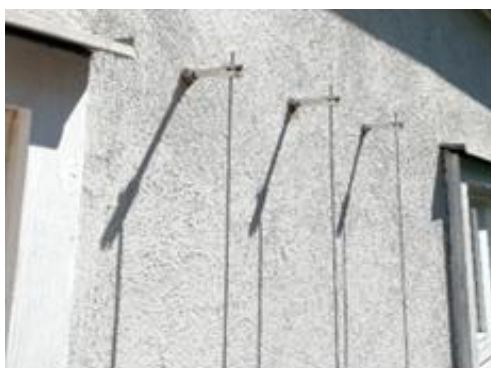
Figura 4: Separadores con cuerdas verticales entre dos ventanas
