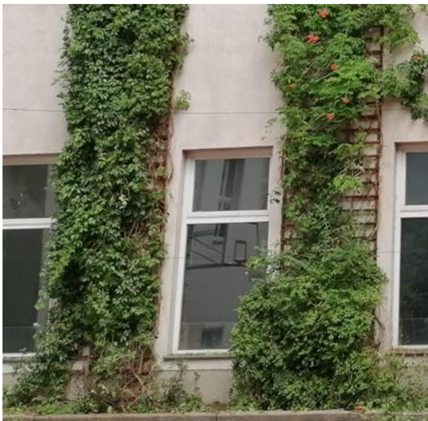
Figura 1: Enrejado de madera como soporte para plantas trepadoras
