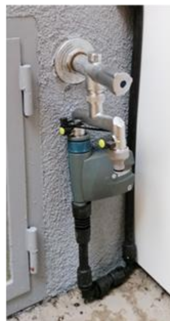
Figura 8: Unidad de control con válvulas solenoides en el interior (izquierda) y con unidad de control a batería en el exterior (derecha)
