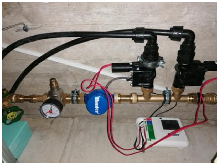
8. irudia: Kontrol unitatea barnealdean solenoide-balbulak dituen (ezkerrean) eta kanpoaldean bateriaren kontrol unitatea duena (eskuinean)
