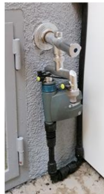
8. irudia: Kontrol unitatea barnealdean solenoide-balbulak dituen (ezkerrean) eta kanpoaldean bateriaren kontrol unitatea duena (eskuinean)
