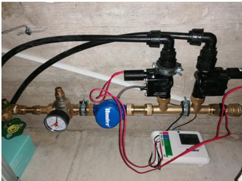
Fíor 8: Aonad rialaithe le comhlaí solenoid san taobh istigh (ar chlé) agus le haonad rialaithe ceallraí amuigh (ar dheis)
