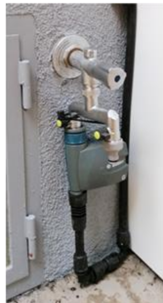
Fíor 8: Aonad rialaithe le comhlaí solenoid san taobh istigh (ar chlé) agus le haonad rialaithe ceallraí amuigh (ar dheis)
