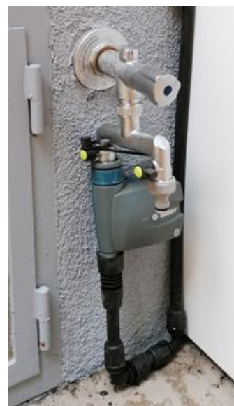
Fíor5 : Aonad rialaithe le comhlaí solenoid laistigh (ar chlé) agus le haonad rialaithe ceallraí lasmuigh (ar dheis)
