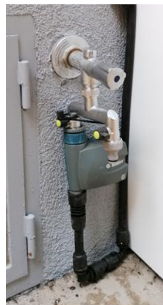
Fíor2 : Aonad rialaithe le comhláí solenoid sa taobh istigh (ar chlé) agus le haonad rialaithe ceallraí amuigh (ar dheis)
