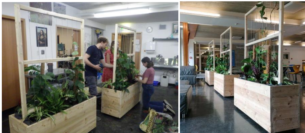
5. ábra: Mobil térelválasztó falak építése és beültetése – Workshop, Graz - iskola
