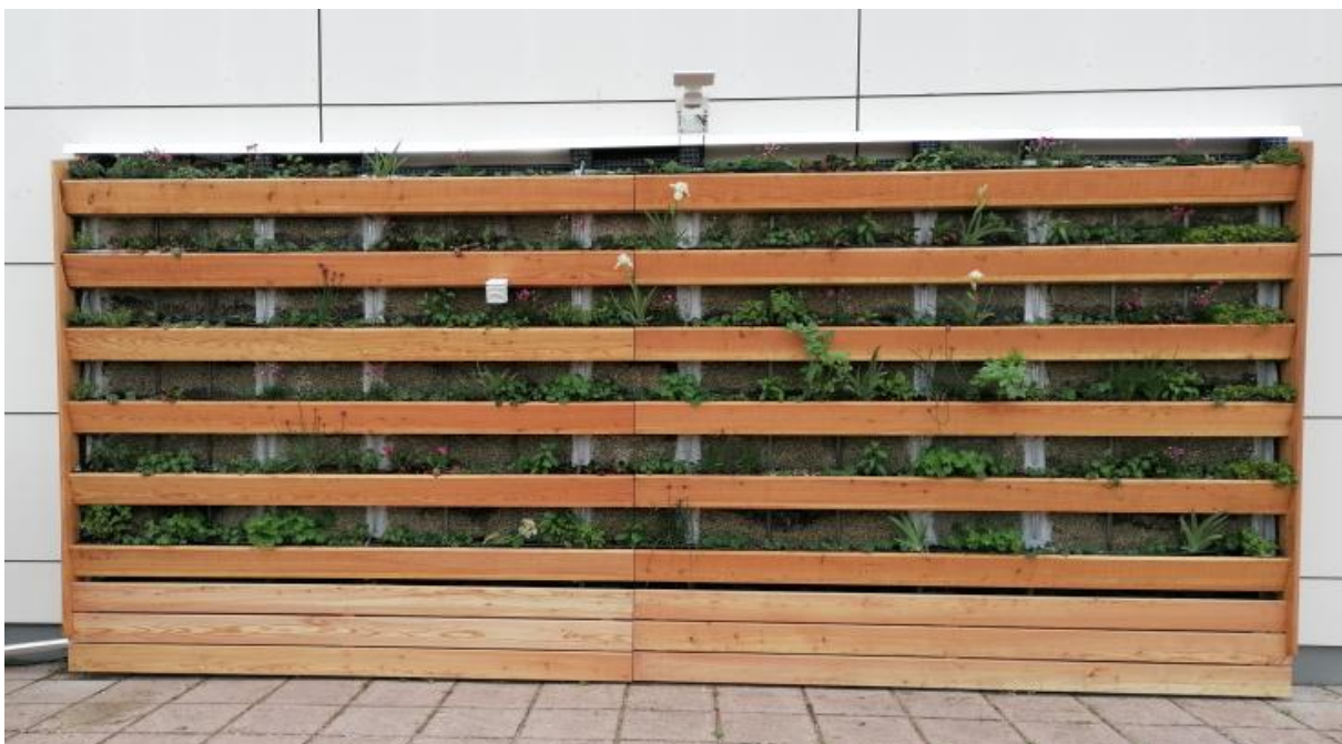
Abbildung 11: Frisch fertiggestellte und bepflanzen EVAPO+ Grünwand im Frühling
