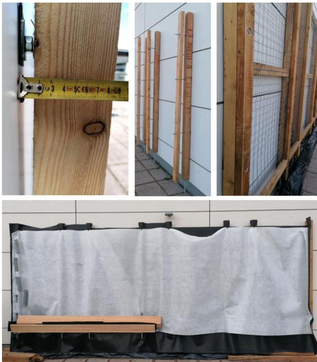
Abbildung 5: Montage Steher mit Abstandhalter und Rückwand aus Gitter, Noppenfolie und Vlies
