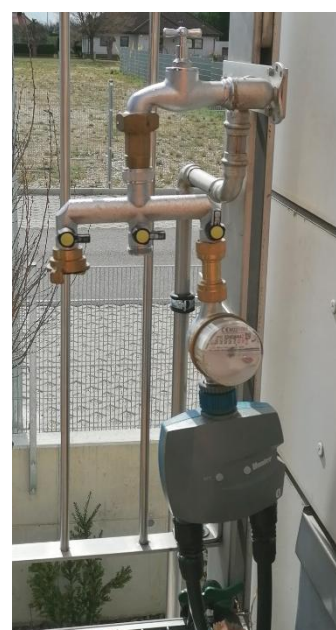
Abbildung 9: Steuerung mit Magnetventilen im Innenraum (links) und mit Batterie-Steuergerät (2 Zonen) außen (rechts)
