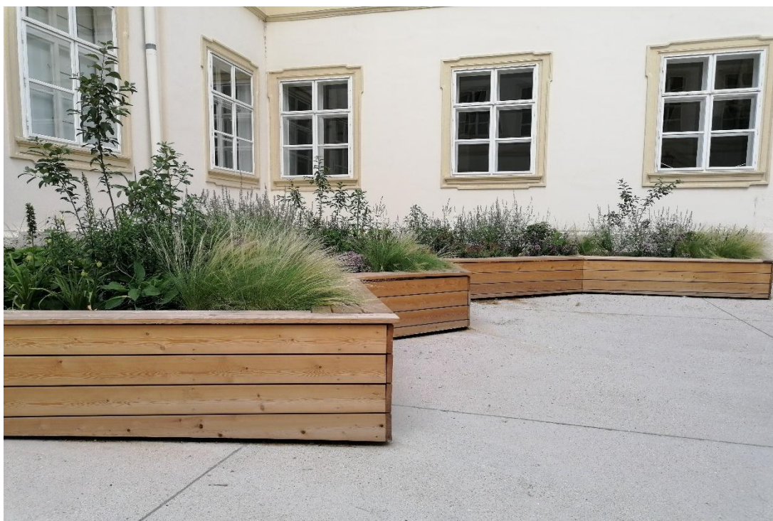
Abbildung 1: Aufgesetzte Flächenbegrünung im Innenhof – „Pop-Up“ ohne Bodenanschluss
