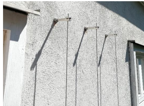
Abbildung 4: Abstandhalter mit senkrechten Seilen zwischen zwei Fenstern
