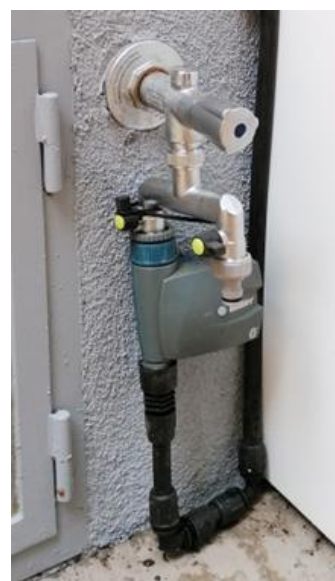
Abbildung 6: Steuerung mit Magnetventilen im Innenraum (links) und mit Batterie-Steuergerät außen (rechts)
