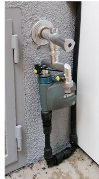
Abbildung 5: Steuerung mit Magnetventilen im Innenraum (links) und mit Batterie-Steuergerät außen (rechts)
